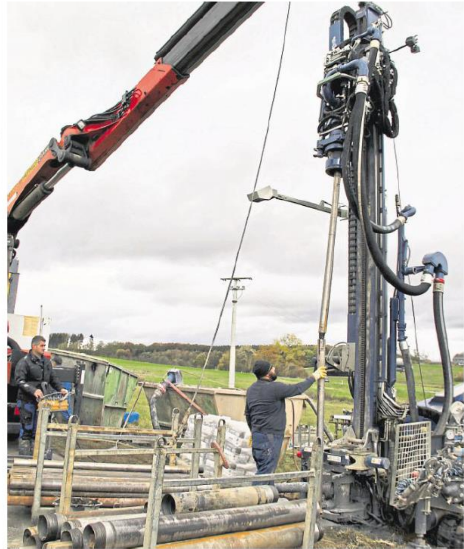
Kenan Efe (links) steuert das Bohrgerät. Es frisst sich Hunderte Meter in die Tiefe. Der Bohrkern wird probiert, um ein geologisches Profil anzulegen, in das Loch wird dann eine Probebohrung gebracht, die die geothermische Leistungsfähigkeit des Untergrundes testet.
